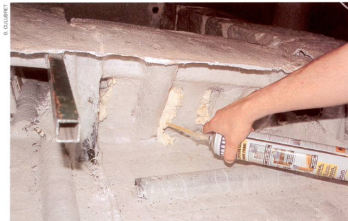
11. Macizado del umbral de la puerta de acceso con espuma de poliuretano.
